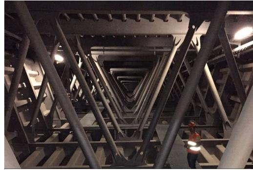
Während der 1,3 km - Wanderung durch die Brücke konnten wir die unterschiedlichsten Brückentragwerke bewundern. Vom zweizelligen Verbundträger mit Stahlholkästen über einen einzelligen Stahlquerschnitt mit ortotroper Fahrbahnplatte bis hin zu vor-gespannten Halbfertigteilen mit Ortbeton-ergänzung war alles dabei. An der Übergangskonstruktion auf der Rettbergsaue gab es noch einen tollen Ausblick auf den Rhein und den Baufortschritt des 2. Brückenüberbaus.
