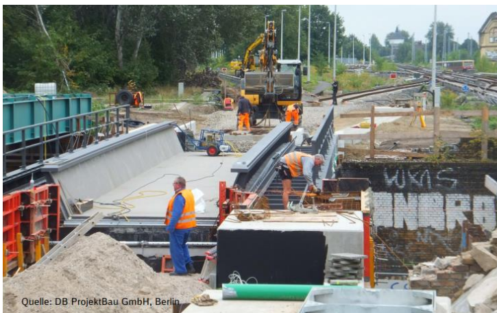
Abbildung 1: Ersatzneubau der EÜ Sterndamm in Berlin als Trogbauwerk mit dickem Fahrbahnblech [Quelle: DB ProjektBau GmbH, Berlin]
